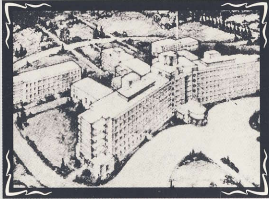
HOPITAL SANATORIUM ST-JOSEPH SOEURS DE MISERICORDE 5689 BOULEVARD ROSEMONT, MONTRÉAL
