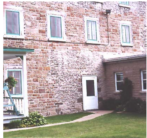
Fig. 105 La jonction de l'aile de la Voûte (1822) et de la seconde aile de la Communauté (1843) montrant l'usage de deux types de pierre : le grès de L'Ange-Gardien, à gauche, et le calcaire de Beauport, à droite. Photo : Paul Trépanier, 2001.
