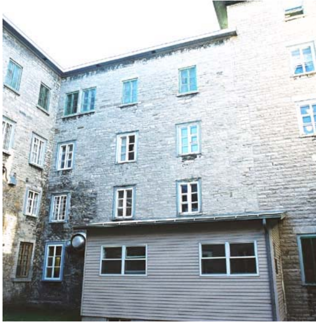
Fig. 15 Dans la cour du Dépôt, subsiste une partie du pavillon de la Boulangerie (1715). AAMHGQ, 79-15 (détail).
