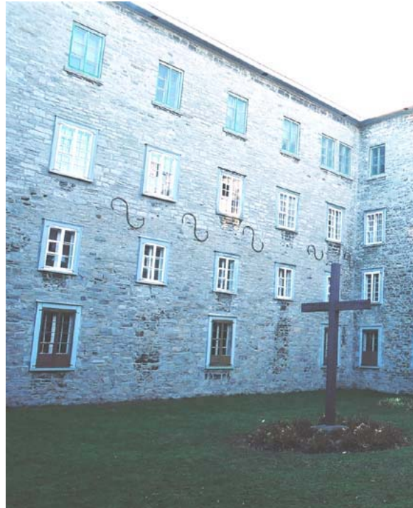
Fig. 9 Façade orientale du bâtiment des Récollets, donnant sur le cloître. AAMHGQ, 81-22.
