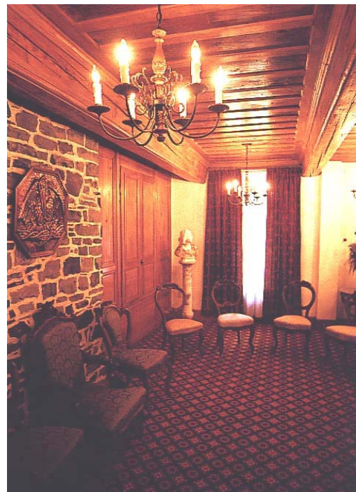
Fig. 160 Plafond à caissons (19 e siècle) dans l'ancien dépôt de l'aile de l'Apothicaire. Ville de Québec, CDÉU, Jonathan Robert, 2001.
