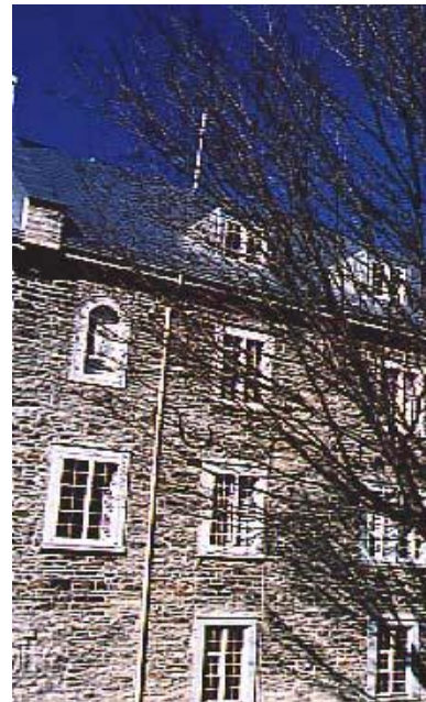
Fig. 79 Trois petites niches, dont une peu visible au-dessus de la fenêtre, intégrées dans la maçonnerie de la façade de l'ancienne buanderie (1856). Photo: Paul Trépanier, 2002.
