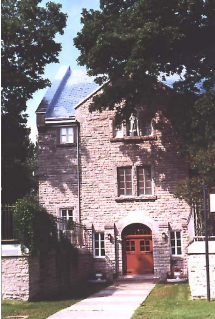
Fig. 38 Façade sur rue de l'aile Notre-Dame-des-Anges (1929). Photo : Paul Trépanier, 2001.
