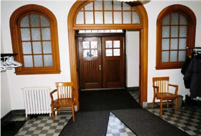
Fig. 176 Les éléments menuisés du vestibule de l'aile Notre-Dame-des-anges (1929). AAMHGQ, 94-14.
