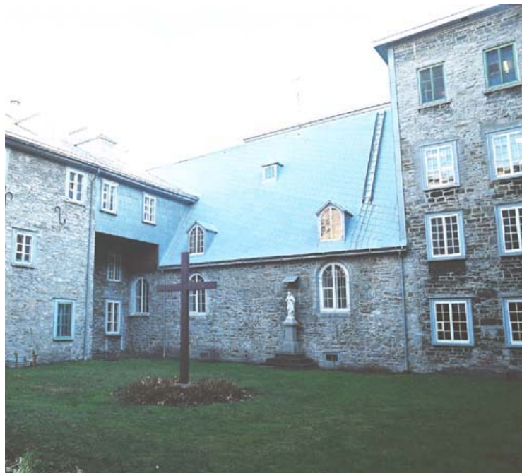
Fig. 4 Façade latérale nord de l'église. AAMHGQ, 81-21.
