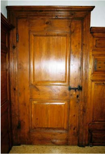
Fig. 132 Cette porte du réfectoire, percée en 1947, remplace une ancienne armoire murale. AAMHGQ, 90-15.
