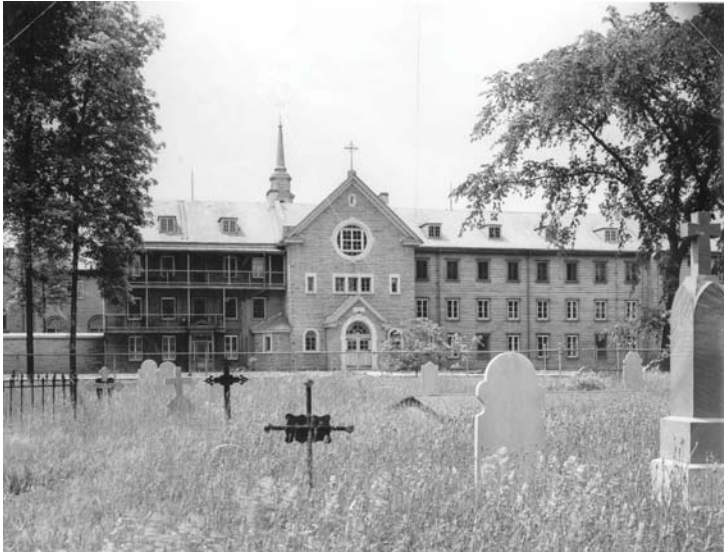
Fig. 47 La façade de l'église, peu après sa construction (1949). AAMHGQ, album 1.12.8.39, p. 22. Photo : Walter Edwards.
