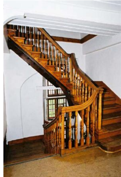
Fig. 156 L'escalier entre le premier et le second étage du bâtiment des Récollets. AAMHGQ, 96-13.
