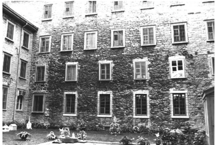
Fig. 14 Façade nord de l'aile de l'Apothicaierie, donnant à l'origine sur la rivière Saint-Charles, de nos jours sur l'ancienne cour du Dépôt. Ville de Québec, CDÉU.
