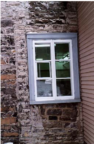
Fig. 122 Le modèle de fenêtre le plus courant à l'Hôpital Général depuis 1850. Photo : Paul Trépanier, 2002.
