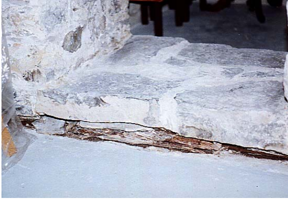
Fig. 99 Mur de maçonnerie du premier monastère des Récollets (1620), au sous-sol de la sacristie, reposant sur une sole de bois. Photo : Paul Trépanier, 2002.
