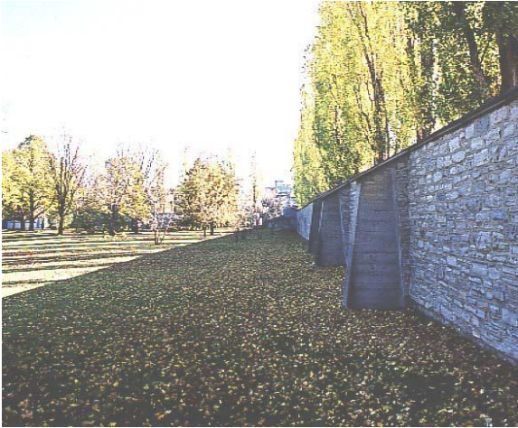
Fig. 185 La section ouest du jardin de la communauté. AAMHGQ, 85-20.
