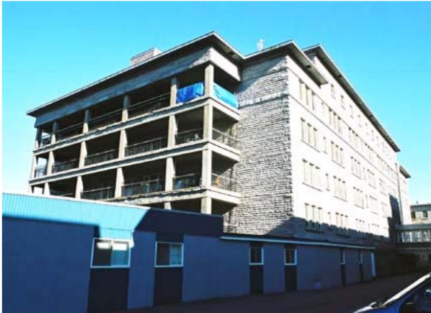
Fig. 50 Façades sud et ouest de l'aile Saint-Joseph. AAMHGQ, 80-06.
