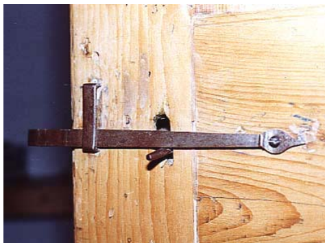
Fig. 143 Ancienne porte d'une cellule de l'aile de 1737 aujourd'hui dans le bureau de la supérieure. Ci-haut : détail de la platine et de l'entrée de serrure. Ci-bas : clenche sur la face intérieure de la porte. Photos : Paul Trépanier, 2002.
