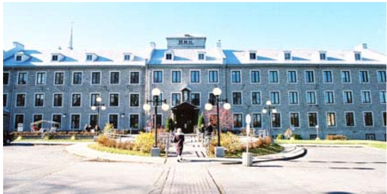
Fig. 61 La façade de l'hôpital en 2001. AAMHGQ, 79-09.
