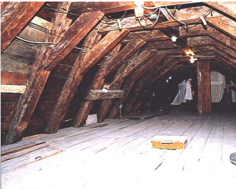
Fig. 112 La charpente de l'église (1673). AAMHGQ, 102-03.
