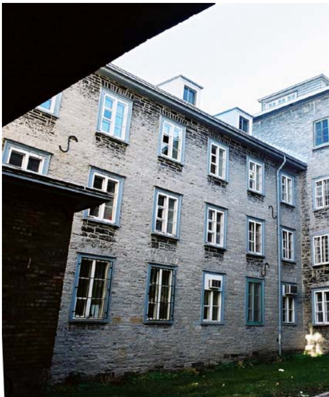
Fig. 33 Façade occidentale de l'aile du Dépôt donnant sur une cour intérieure, la cour du Dépôt. AAMHGQ, 79-14 (détail).
