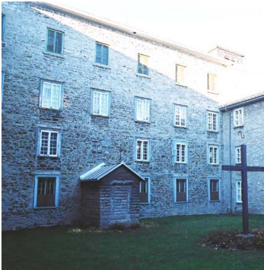
Fig. 13 Façade sud de l'aile de l'Apothicaierie, donnant sur le cloître. AAMHGQ, 81-20.
