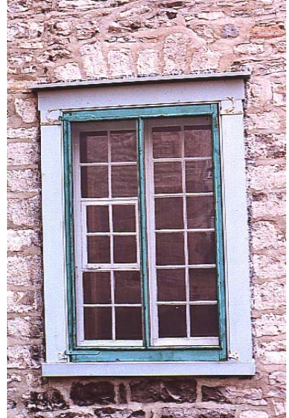
Fig. 102 Fenêtre à la façade ouest du bâtiment des Récollets. On peut distinguer sous l'encadrement de bois la forme arquée du linteau. Photo : Paul Trépanier, 2001.
