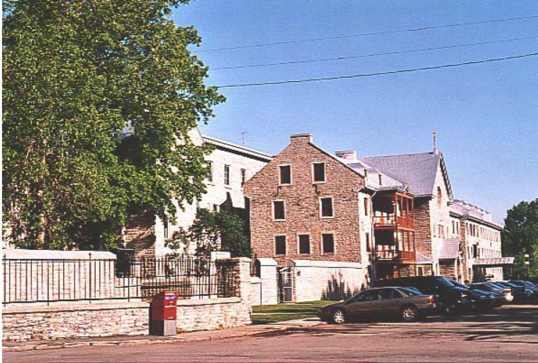
Fig. 179 L'Hôpital Général vu de l'entrée. Photo : Paul Trépanier, 2002
