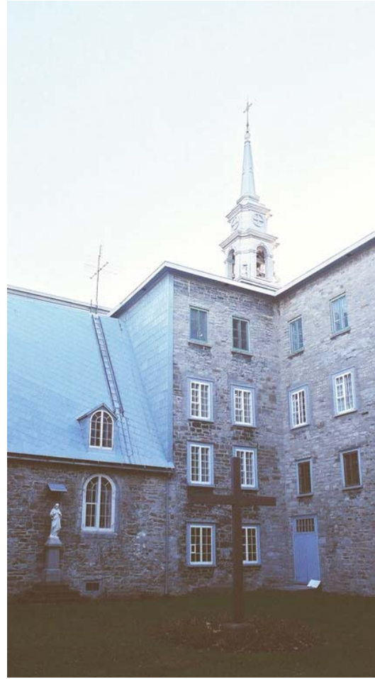
Fig. 68 Vue latérale de l'aile de la sacristie et du chœur des Récóllets, construite au chevet de l'église Notre-Dame-des-Anges. AAMHGQ, 81-23.
