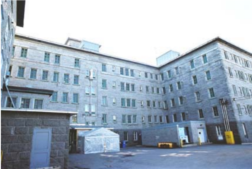
Fig. 49 Façade nord de l'aile Saint- Joseph. AAMHGQ, 79-19.
