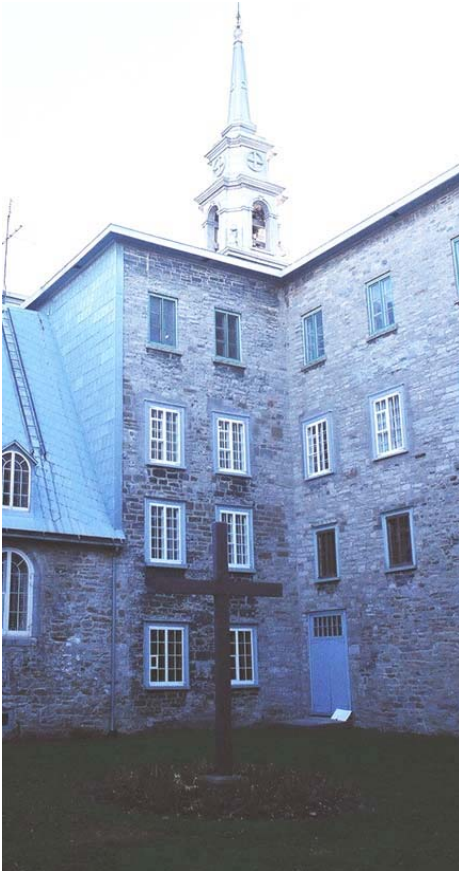
Fig. 6 Façade latérale nord de la sacristie. AAMHGQ, 81-23 (détail).
