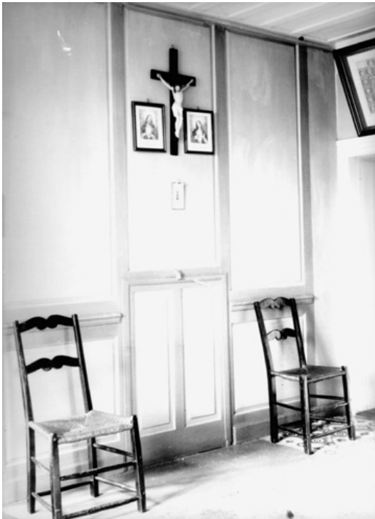
Fig. 135 Les lambris du rez-de-chaussée du presbytère en 1928. Ils ont disparu lors de la rénovation de 1949. Archives photographiques Traquair, C.A.C., Université McGill, 105818.
