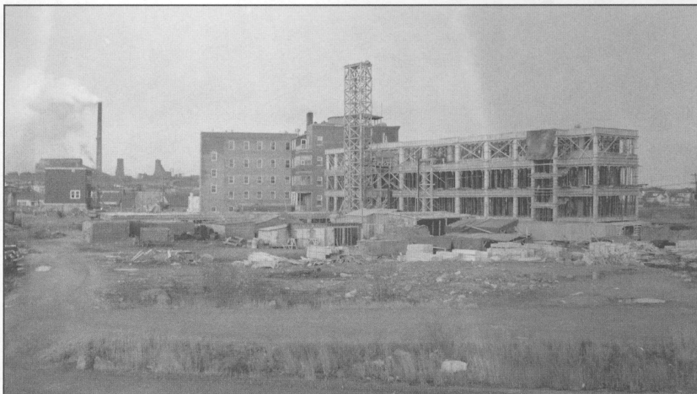
L'Hôpital Youville pendant la construction des annexes, vers 1946. / The construction of the new additions of Youville Hospital, around 1946. P124,P334-46-6
