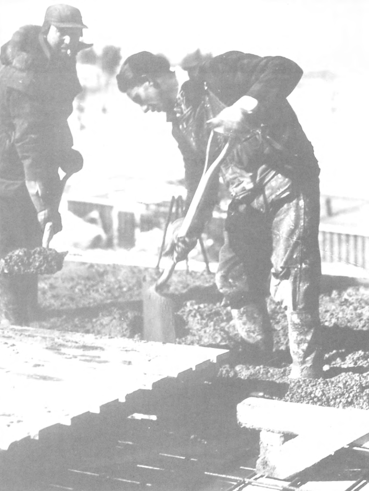
Coulée de Béton à l'Hôpital St-Sauveur, 1949. (Archives CHVD)
