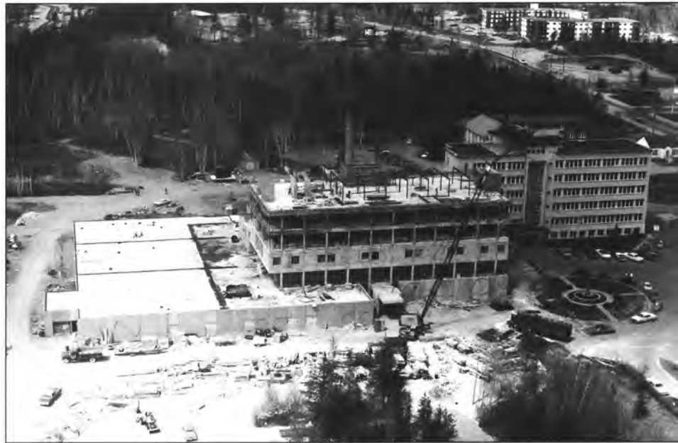
Les travaux de l'Hôpital avancent bien (1975). (Source : L'Écho )
