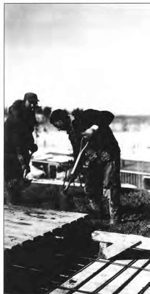
Coulée de Béton à l'Hôpital St-Sauveur, 1949. (Archives CHVD)
