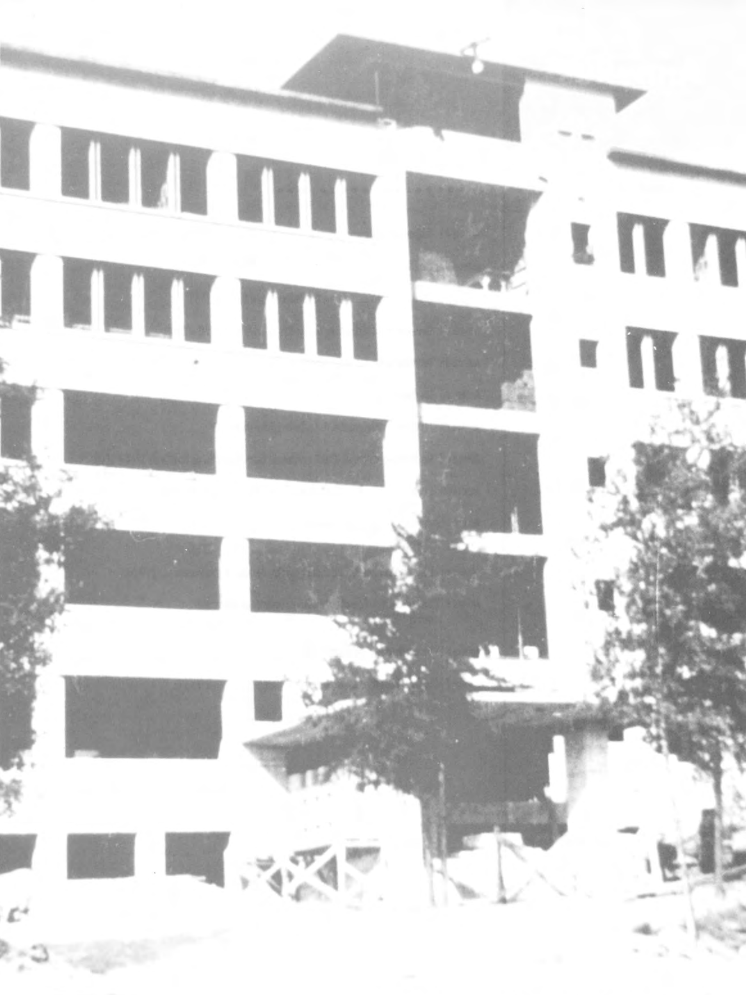
L'Hôpital en construction, 1950 (Source : Société d'histoire de Val-d'Or)
