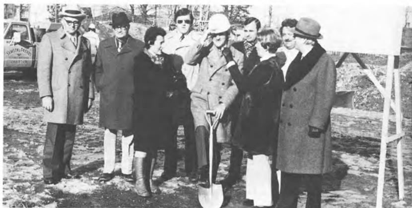
Première pelletée de terre - Centre d'accueil d'hébergement
