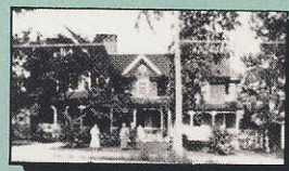
Hôpital de Van Buren, Maine, E.U.
