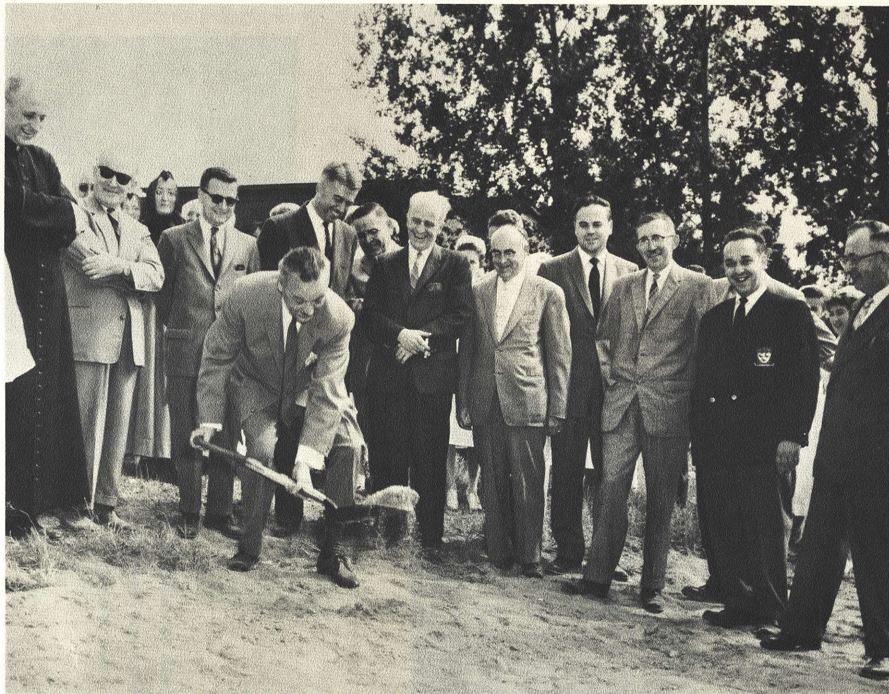
On voit ici S. H. le Maire Armand Nadeau s'apprêtant à soulever la première pelletée de terre marquant l'ouverture des travaux de construction de la nouvelle école d'infirmières de l'Hôpital St-Vincent-de-Paul.
