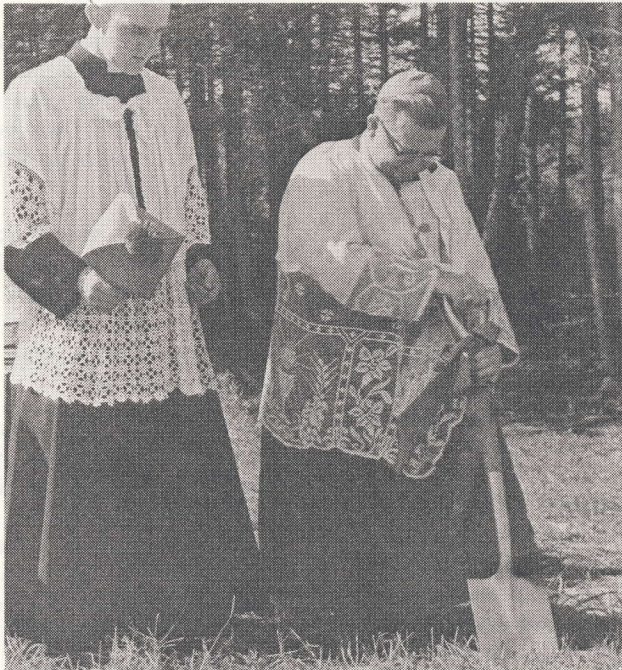
Le 7 septembre 1964, Mgr Paul Bernier accompagné de M. Pierre-Paul Martin, lève la première pelletée de terre en vue du nouvel hôpital. Les travaux commenceront en août 1969...
