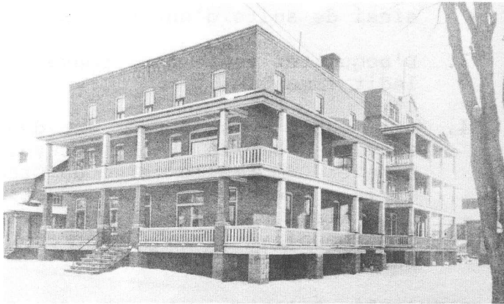
Photo prise en mars 1927 du 3 e hôpital Ste-Croix. À gauche, l'ancien hôtel de St-Germain recons- truit en 1926 et à droite, la première annexe bâtie en 1930
