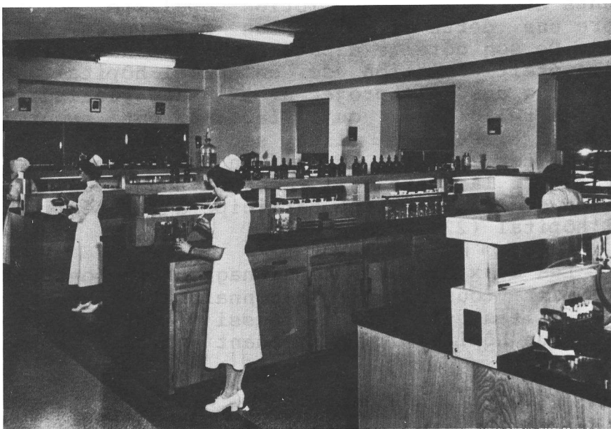
Le laboratoire du nouvel hôpital Ste-Croix
