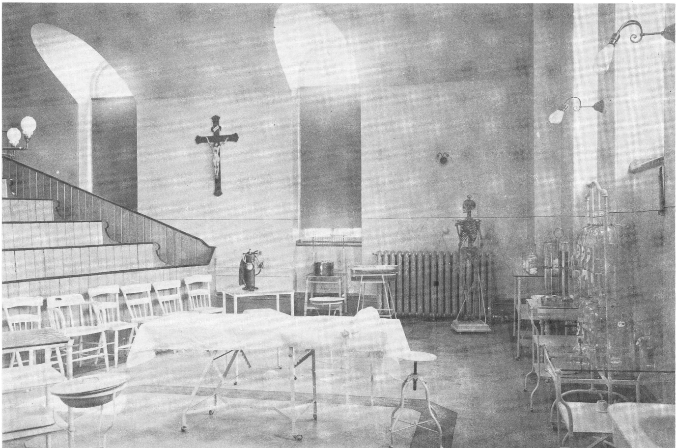
Grande salle d'opération (1905)
