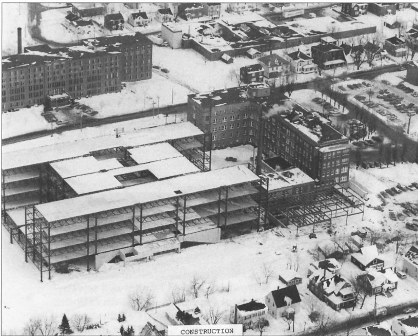
Construction de l'hôpital.
