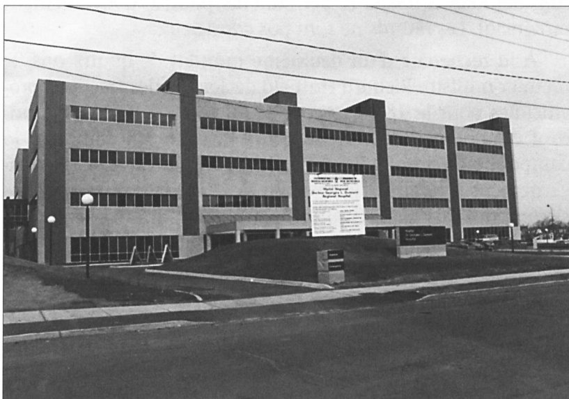
Vue de l'hôpital terminé au printemps 1975.
