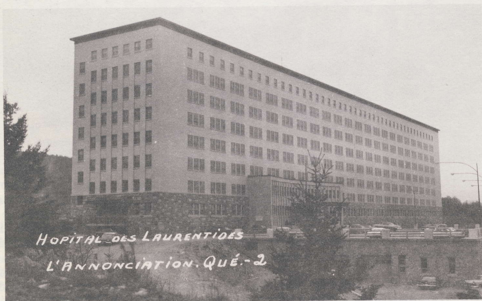
L'Hôpital des Laurentides, près de Mont-Laurier
