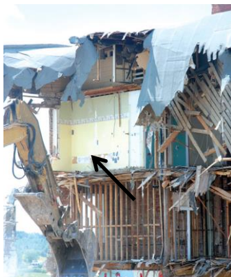
Le mur entre le premier et la deuxième partie de l'édifice.
