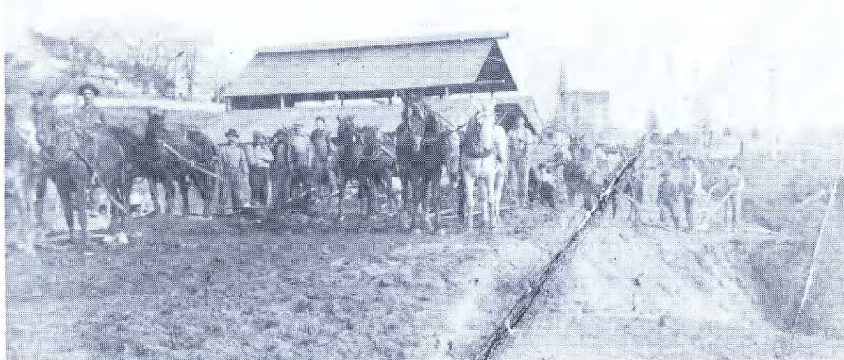
Préparation du terrain de la briquerie
